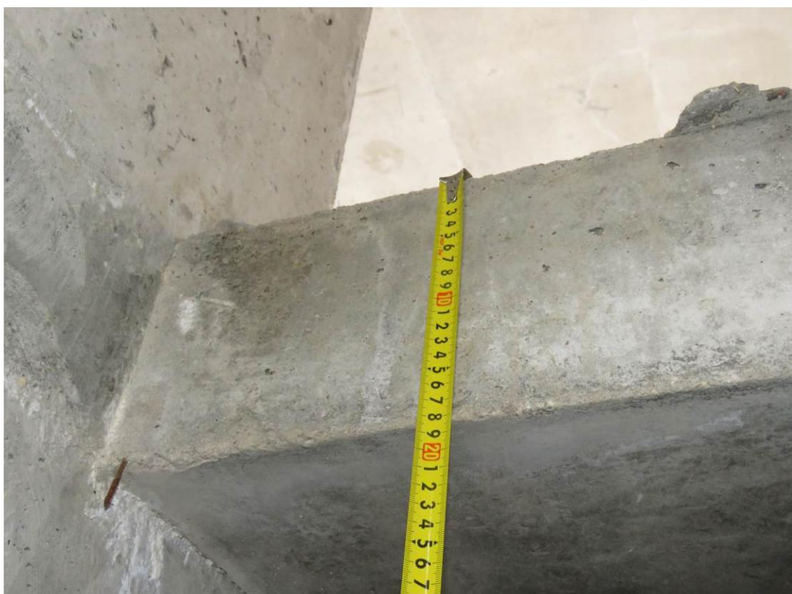
**Рис. 2.4. Уточнение толщины монолитного ж/б перекрытия 1-го этажа**
