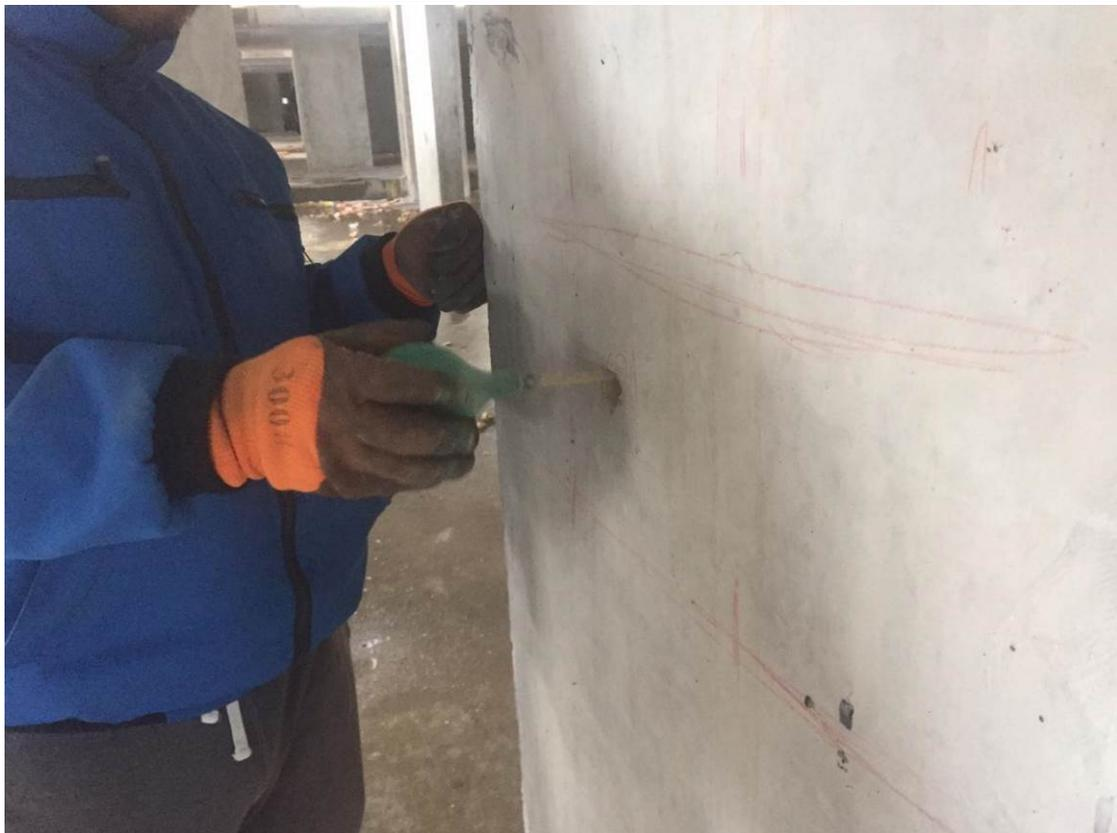
**Рис. 4.2.2. Продувка отверстия от пыли в монолитном железобетонном пилоне в осях Д/4/7/3-7/4**
