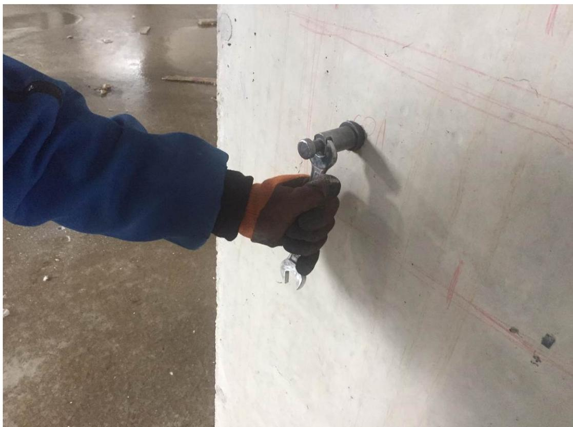
**Рис. 4.2.3. Установка анкерного устройства и тяги в отверстии монолитного железобетонного пилона в осях Д/4/7/3-7/4**
