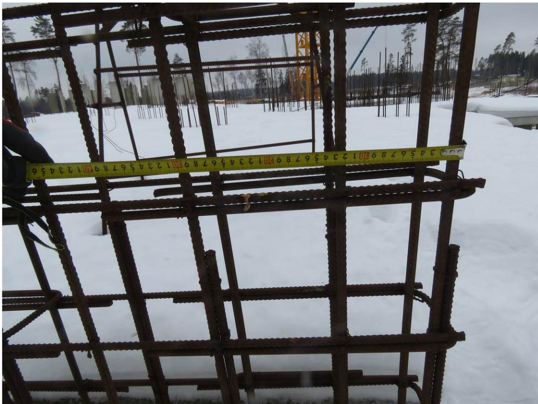
**Рис. 3.2.8. Замер шага вертикальных стрежней арматуры в выпусках монолитного пилона 2-го этажа секции 4**
