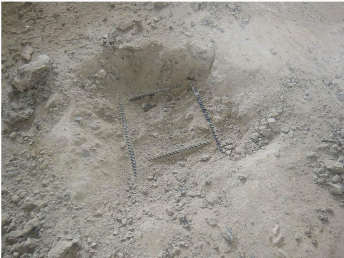
**Рис. 3.1.6. Общий вид вскрытия фундаментной плиты в верхней зоне на пересечении осей РР-ТТ и 11-14**
