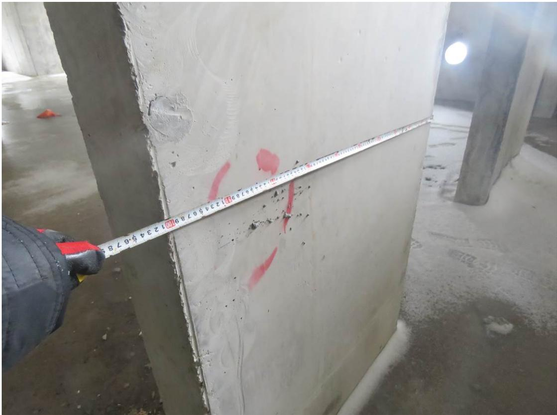
**Рис. 3.2.5. Замер ширины монолитного ж.б пилона подвального этажа (1000 мм)**
