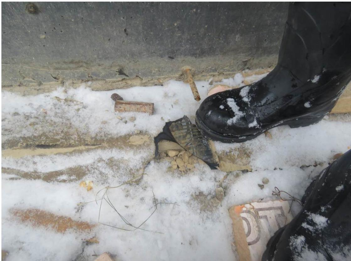
**Рис. 3.1.5. Наличие горизонтальной гидроизоляции фундаментной плиты из двух слоев гидростеклоизола**
