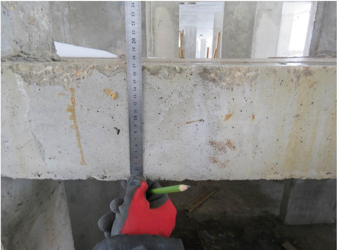
**Рис. 3.3.2. Замер толщины монолитной ж.б. плиты перекрытия (170 мм) в осях 4/3-4/5÷Д/4-Д/6**
