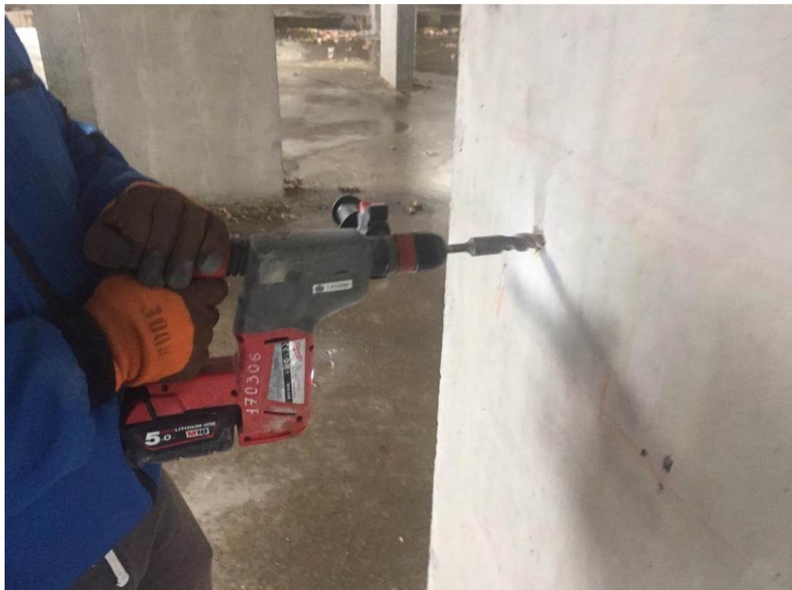
**Рис. 4.2.1. Сверление отверстия в монолитном железобетонном пилоне в осях Д/4/7/3-7/4**
