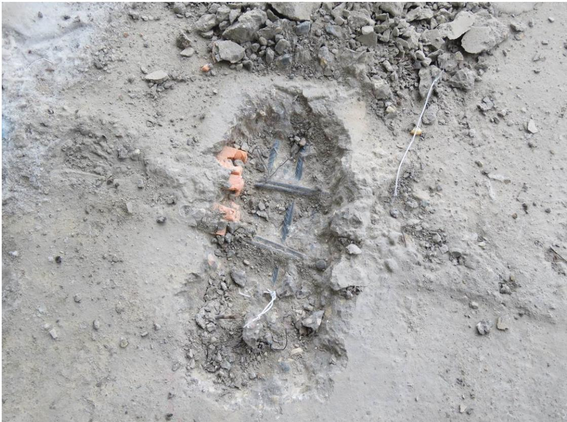
**Рис. 3.3.5. Общий вид участка вскрытия плиты перекрытия подвала (зона верхнего армирования)**
