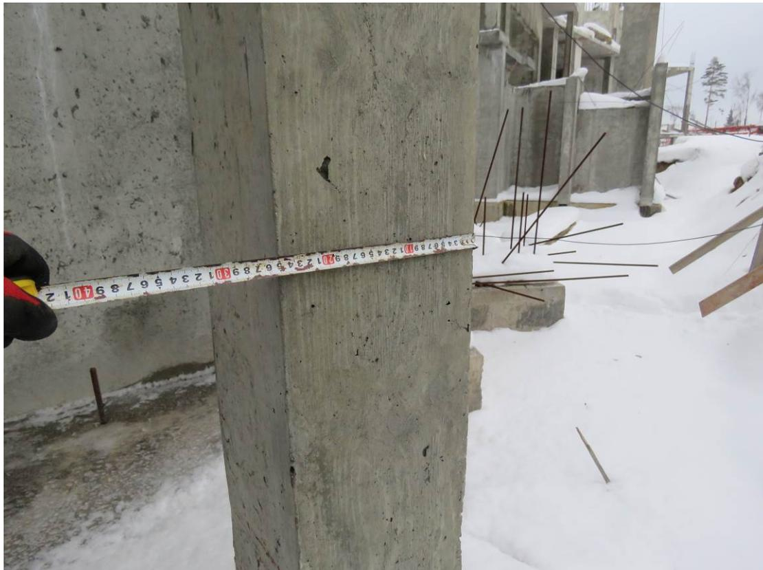
Рис. 2.1. Уточнение сечения наружной колонны в осях Д/6/2
