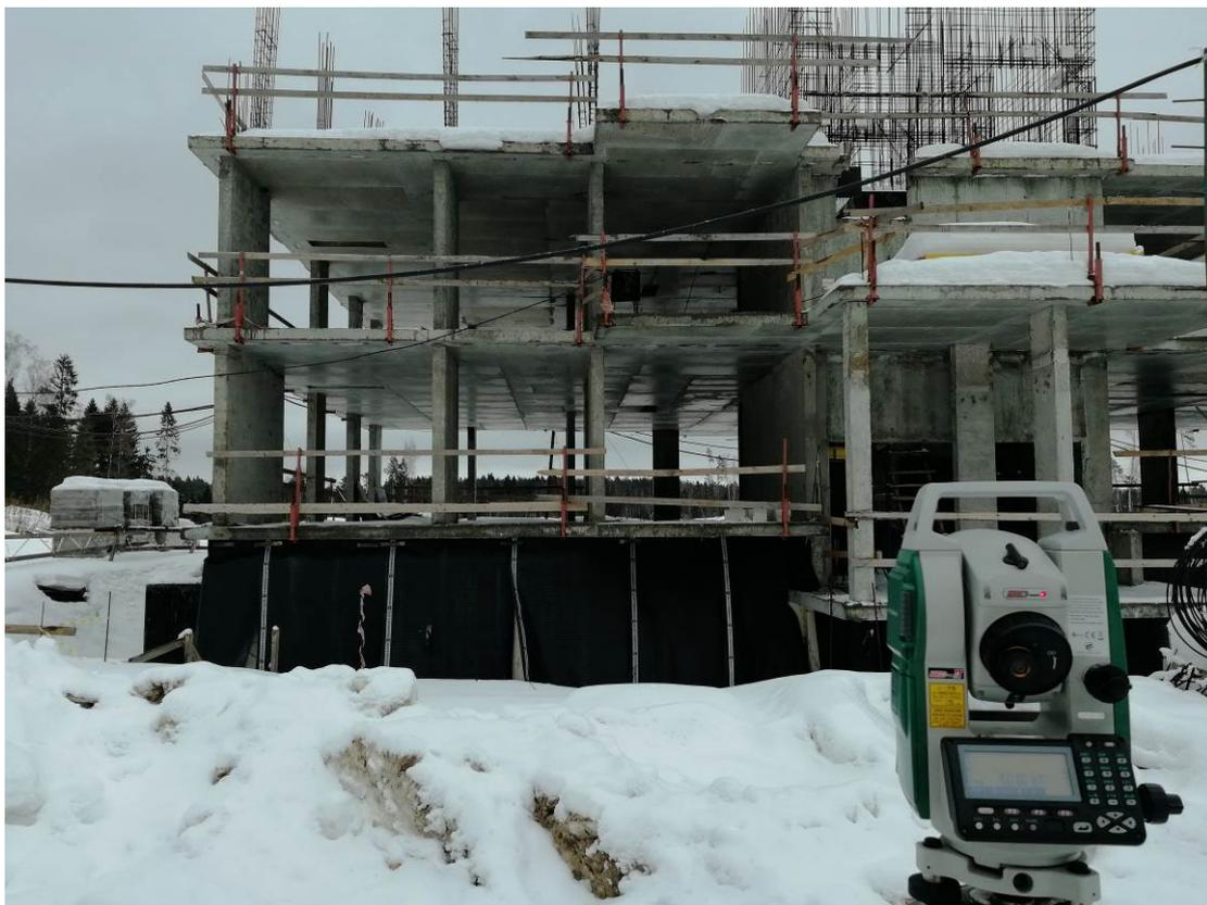
**Рис. 2.2.1. Определение отклонений от вертикали и горизонтали строительных конструкций жилого здания при помощи электронного тахеометра «Sokkia RX-550»**
