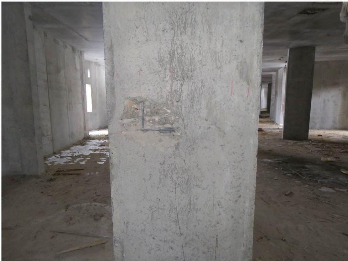
**Рис. 3.2.7. Общий вид вскрытия монолитного пилона подвального этажа**
