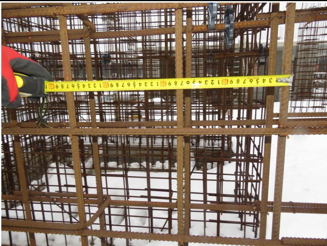
**Рис. 3.2.9. Замер диаметра вертикального армирования в монолитной стене в уровне 2-го этажа**
