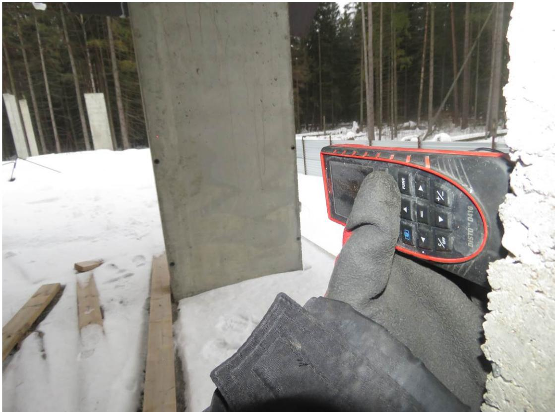
**Рис. 3.2.6. Замер шага монолитных пилонов 1-го этажа**
