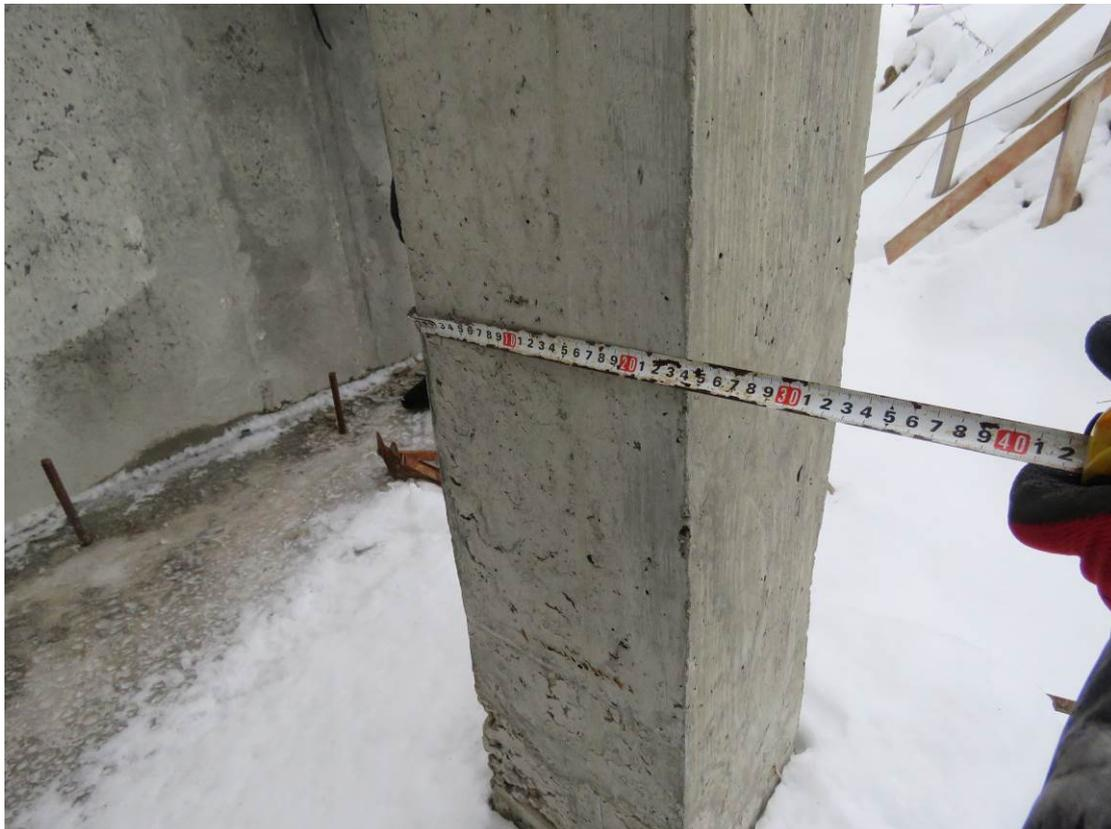
Рис. 3.2.3. Замер сечения монолитной ж.б колонны подвального этажа (250 мм)
