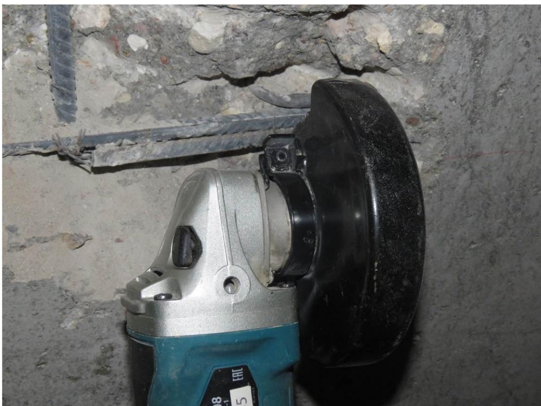
**Рис. 3.2.7. Общий вид отбора проб арматурных стержней в месте проведения вскрытия монолитного пилона подвального этажа**
