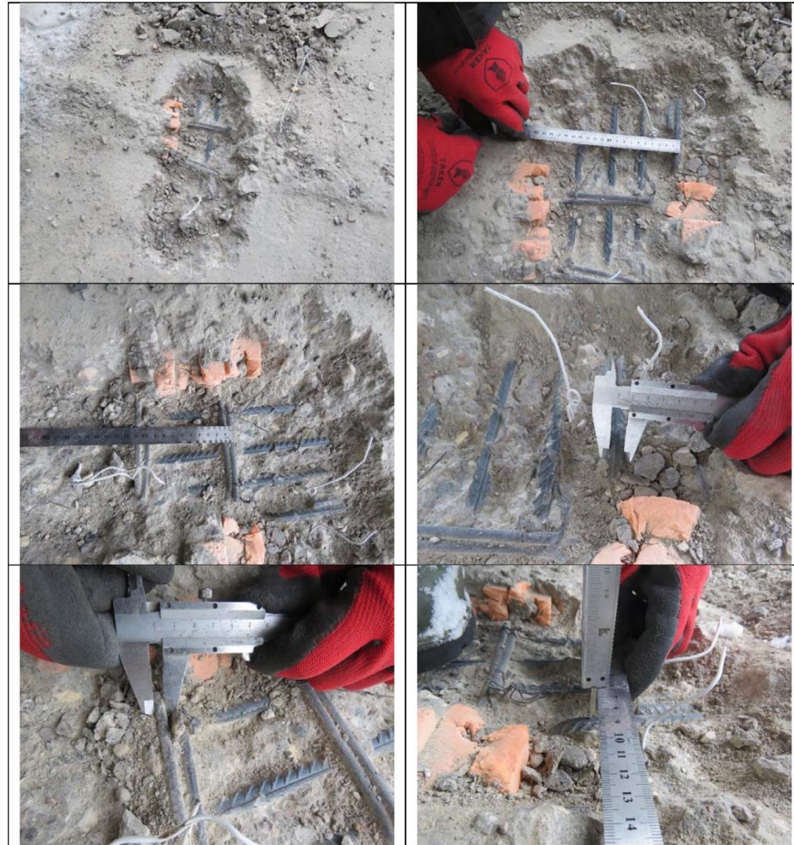
Вскрытие №6. Плита перекрытия 1-го этажа в осях «Д/4-Д/5÷4/6-5» (нижн. арм.)
