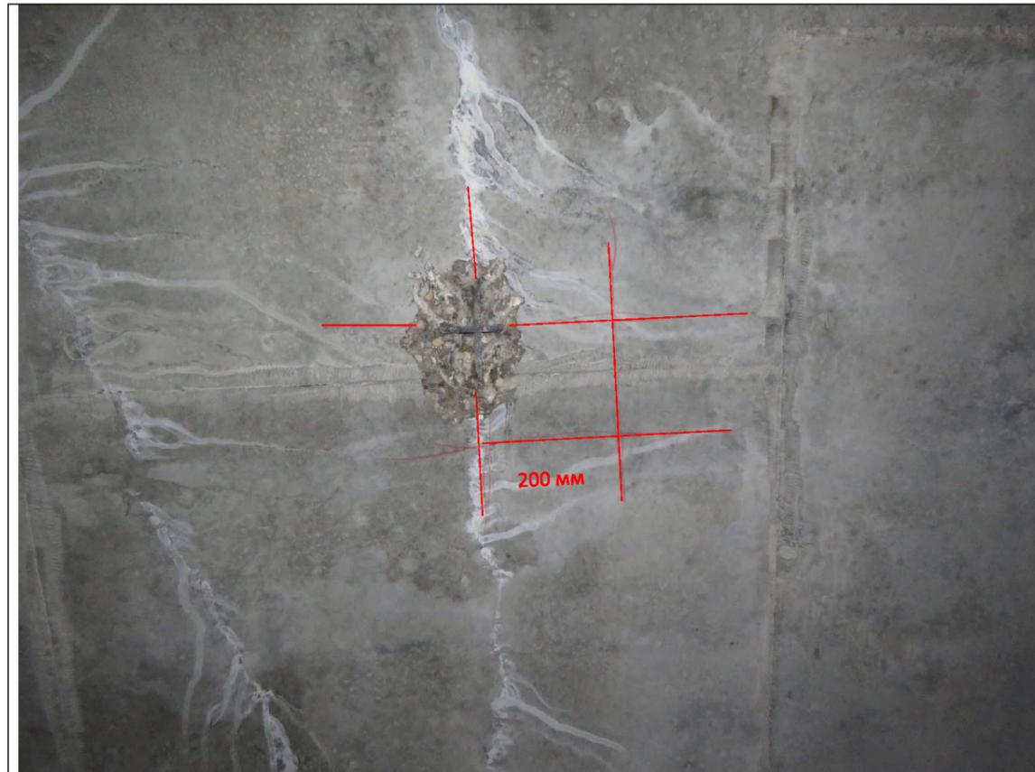
Вскрытие №4. Плита перекрытия подвала в осях «Д/3-Д/3.1÷4/2-4/3» (верх. арм.)
