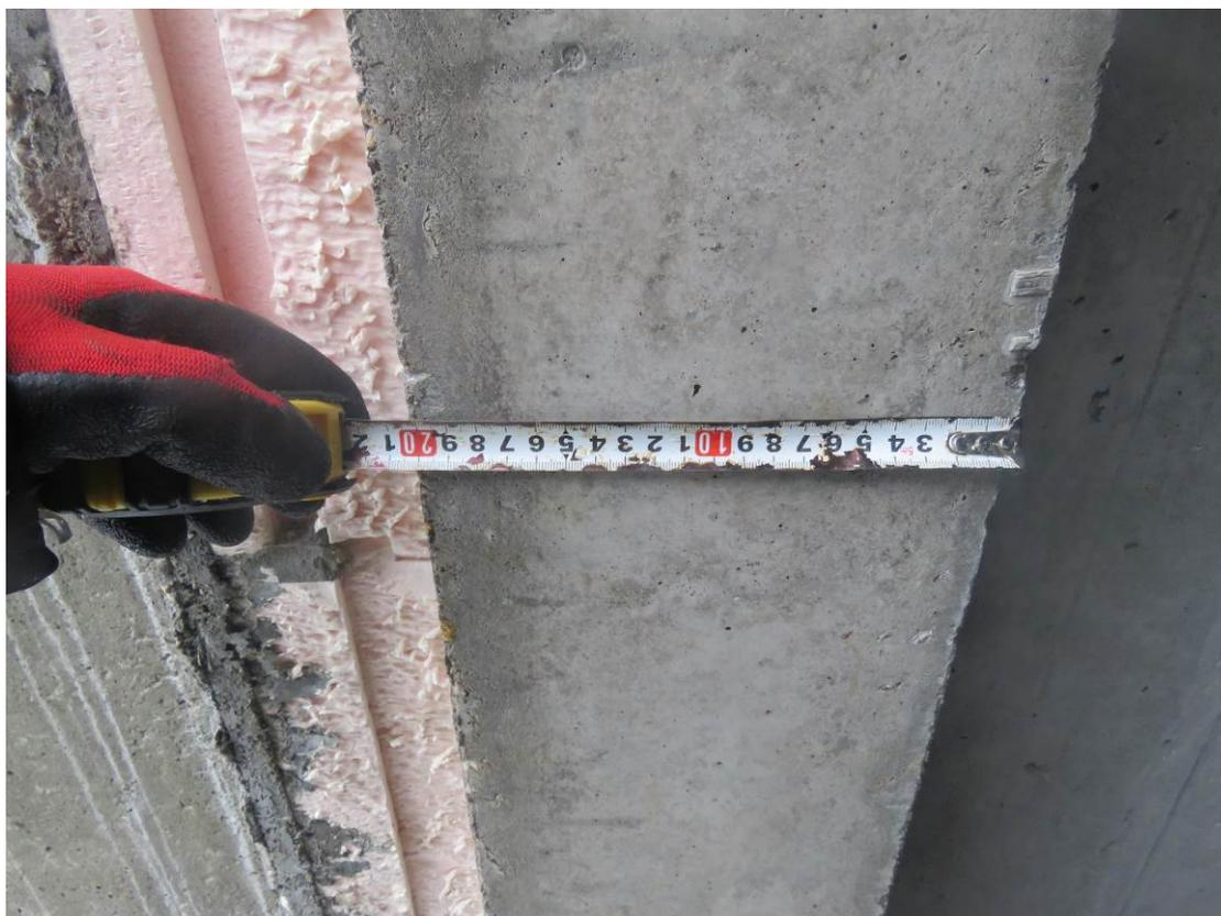
**Рис. 2.3. Уточнение толщины наружной монолитной стены подвала**
