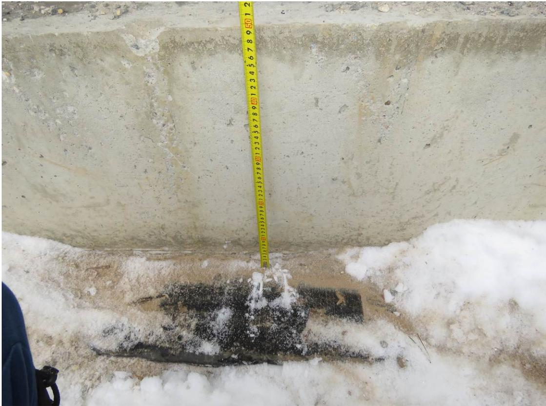
**Рис. 3.1.4. Уточнение сечения фундаментной плиты секции 7 ( 500 мм)**
